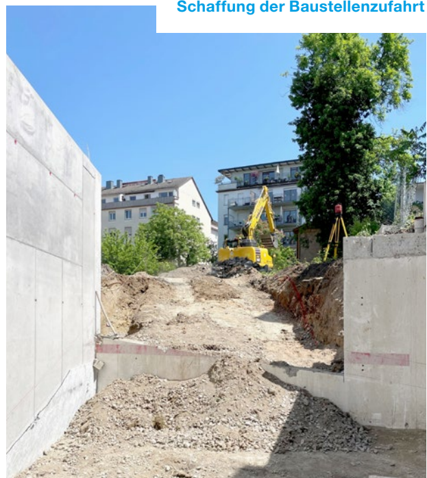
Schaffung der Baustellenzufahrt
