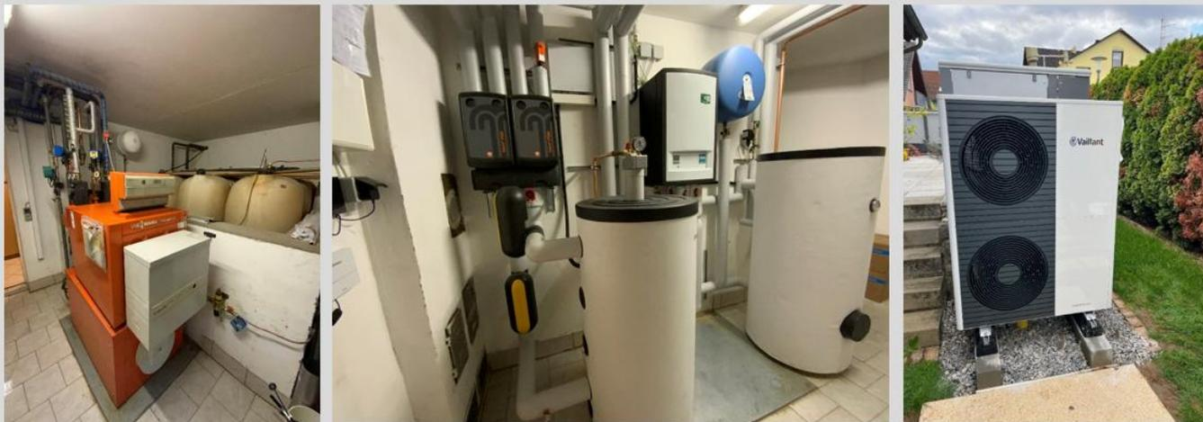
Ölheizung mit 24 kW Leistung ca. 30 Jahre alt in einem 2-Familienhaus in Sommerhausen. Dach wurde kürzlich saniert und gedämmt. Die neu berechnete Heizlast ergab 10 kW für das Haus. Die Wärmepumpe schafft ca. 8,5 kW bei Normaußentemperatur von  $-11^{\circ}\text{C}$ , das ergibt einen Bivalenzpunkt von  $-9^{\circ}\text{C}$ .
