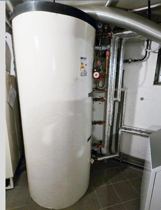
Gas Brennwert Heizung 19kW Leistung 14 Jahre alt + BHKW 2,3 kWh Heiz- und 1 kWh Stromleistung, 1.000 Ltr. Pufferspeicher
