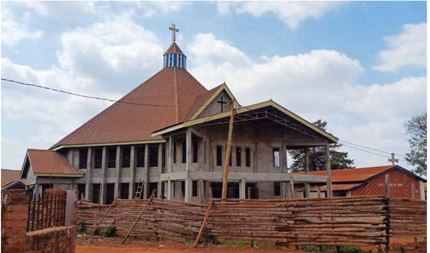
Kirchenneubau in Mbinga, rechts ist die bisherige Kirche zu sehen. Im Neubau werden bereits Gottesdienste gefeiert - das Dach ist gedeckt, der Bau geht weiter, wenn wieder Kollektengelder vorhanden sind. Es gibt keine Kirchensteuer.
